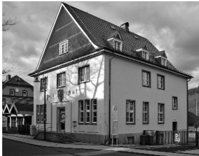
1 Burbach, Nassauische Str.40, vor der Instandsetzung 2008.
