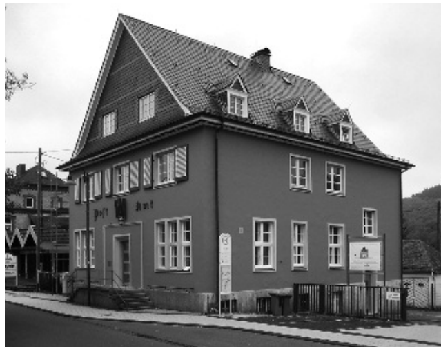
2 Burbach, Nassauische Str.40, nach der Instandsetzung 2009.
